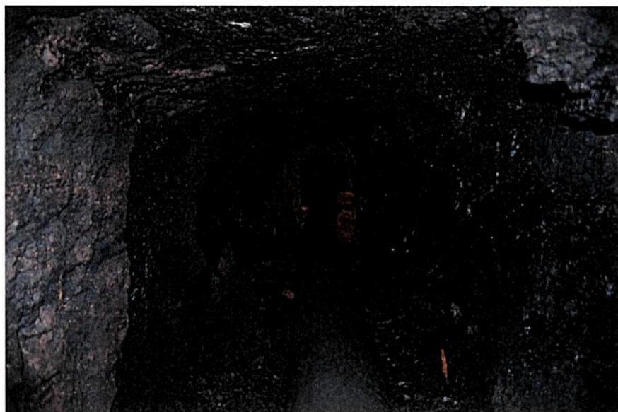
Fot. 2. Widok w kierunku południowym, odcinek środkowy. Odspojone łaty zwietrzałego węgla na ociosach i oberwany węgiel zalegający na spągu.
