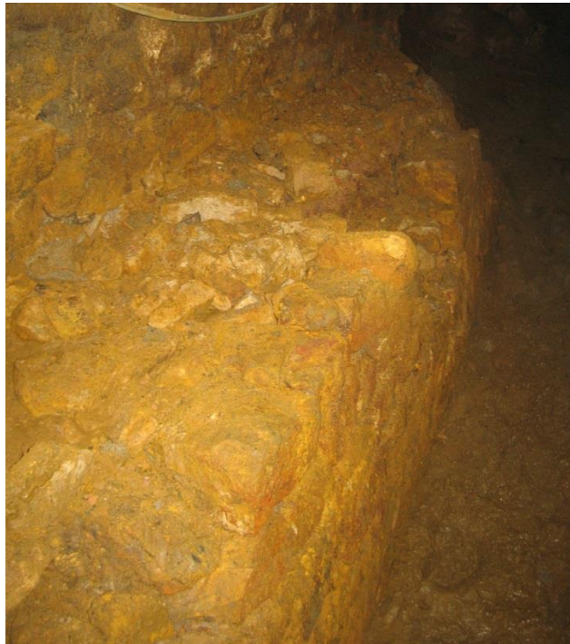
Rys. 2.3. Widok fragmentu rozluzowanej i uszkodzonej półki z kamienia naturalnego stanowiącej brzeg kanału wodnego
