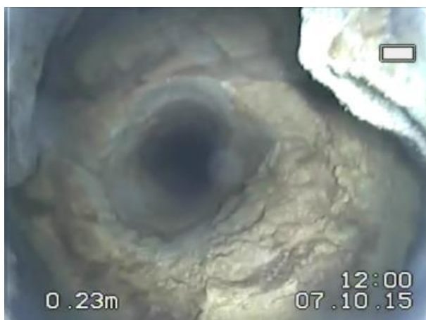
Rys.4.2.2. Pustka za obudową kamienną.
