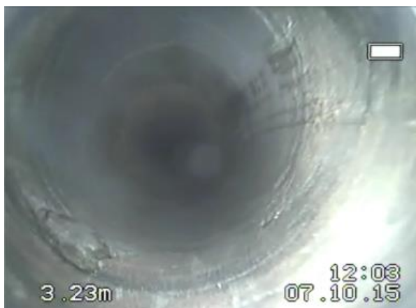
Rys.4.2.10. Ubytki skalne o wielkości do 10 mm.
