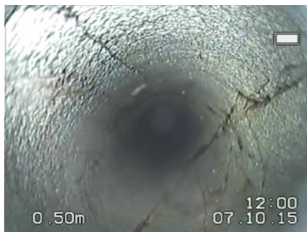
Rys.4.2.3. Sieci przecinających się skośnych spękań
