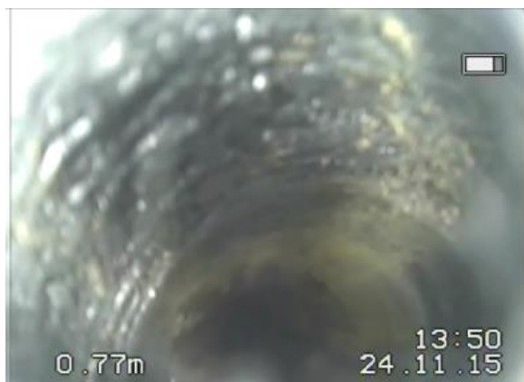
Rys.4.2.12. Drobne spękania poziome i prawie poziome o rozwierciu do 1 mm.
