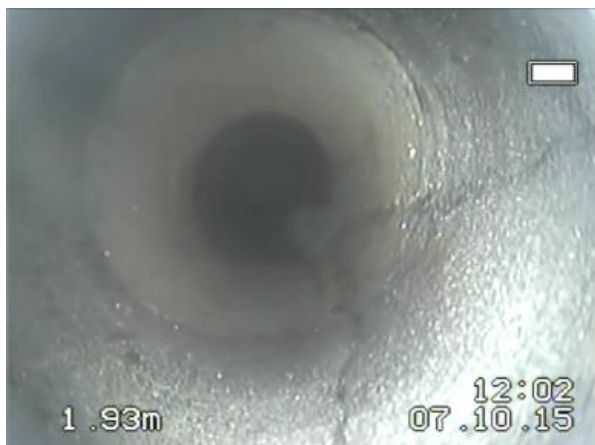
Rys.4.2.8. Skośne spękania o rozwarciu do 1 mm
