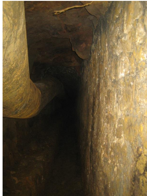
Rys. 2.6. Widok chodnika „Dechen” na wybiegu na wybiegu 40 – 47,3 m: a) widok przytamek na wybiegu 40 m, b) widok ociosu zachodniego zabezpieczonego murem kamiennym
