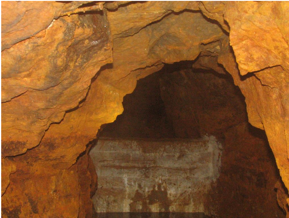
Rys. 2.2. Widok na przytamek, około 60m od wlotu wyrobiska Sztolni Północnej. Na ciosie zachodnim są widoczne ślady wskazujące na pierwotny poziom wody w wyrobisku.
