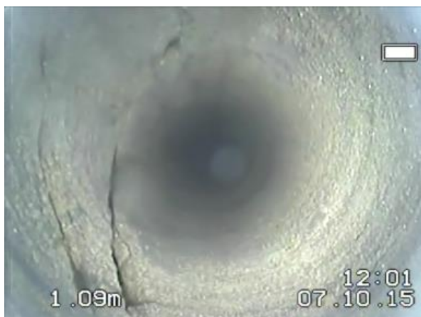
Rys.4.2.6. Skośne spękania poszerzające się do rozwarcia 10 mm.
