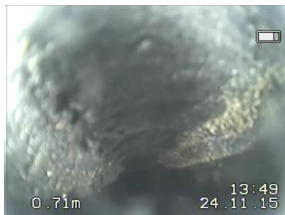
Rys.4.4. Pionowe spękanie o rozwarciu 1 mm.
