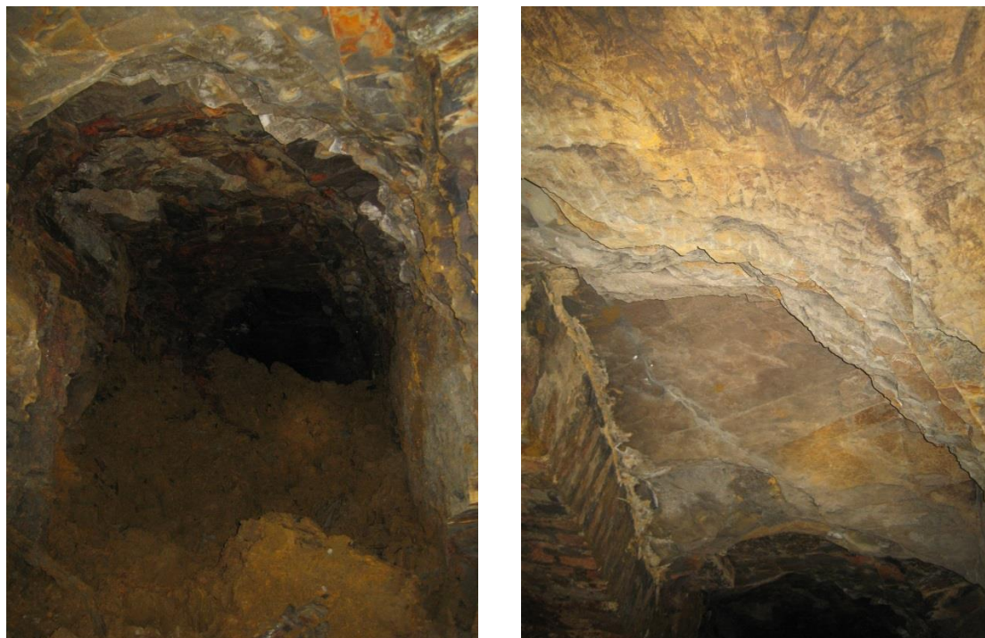
Rys. 2.9. Widok dostępnego fragmentu odcinka wyrobiska wykonanego na wschód od wnęki bez obudowy
