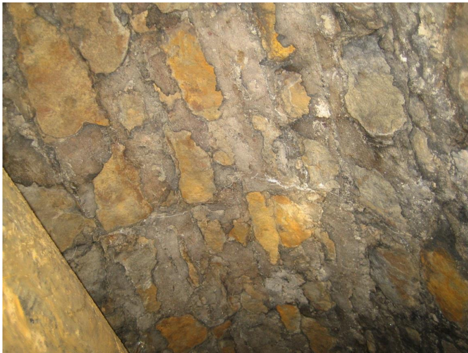
Rys. 2.8. Poprzeczna rysa o rozwierciu do ok. 3 mm na wybiegu ok. 61 m widoczna na całym obwodzie obudowy
