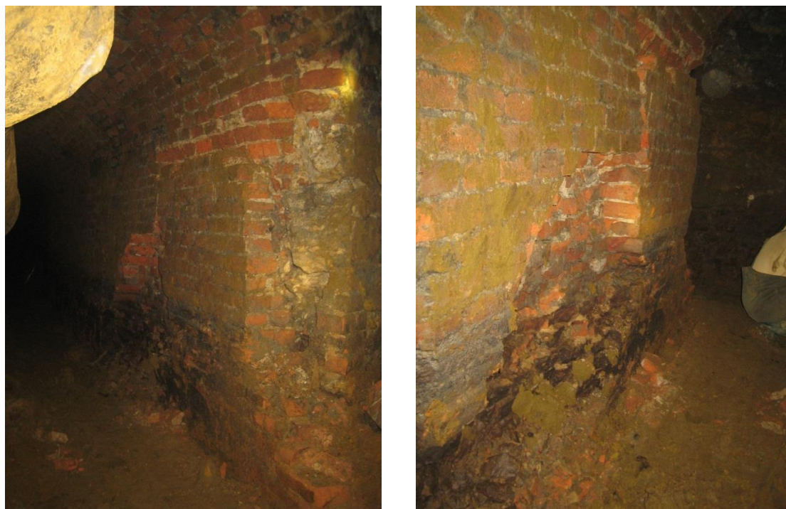
Rys. 2.5. Widok uszkodzonego południowego naroża odgałęzienia chodnika „Dechen” na wybiegu 87m
