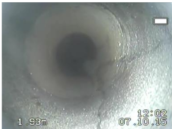
Rys.4.2.8. Skośne spękania o rozwarciu do 1 mm
