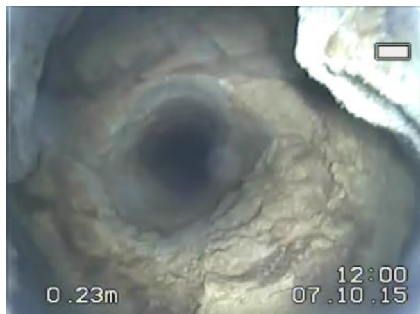
Rys.4.2.2. Pustka za obudową kamienną.
