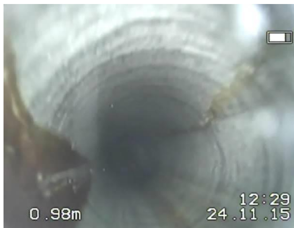
Rys.4.2.13. Spękania skośne ( 80^\circ ) o rozwarciu 1 mm.
