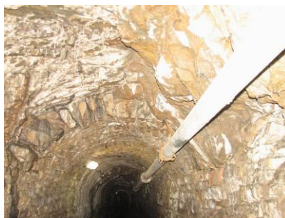
Rys. 2.5. Sztolnia pld. Wzmocnienie stropu obudową murowaną z kamienia łamanego.
