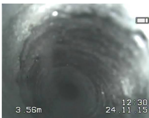
Rys.4.2.17. Spękania skośne o rozwarciu do 1 mm.
