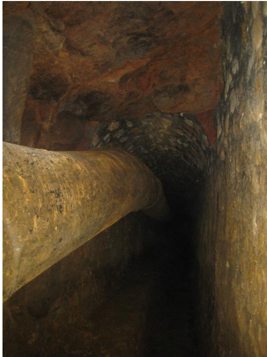
Rys. 2.7. Widok chodnika „Dechen” na południe od 47,3 m wybiegu: a) początek odcinka wyrobiska zabezpieczonego na całym obwodzie obudową kamienną, b) widok wyrobiska w obudowie kamiennej.
