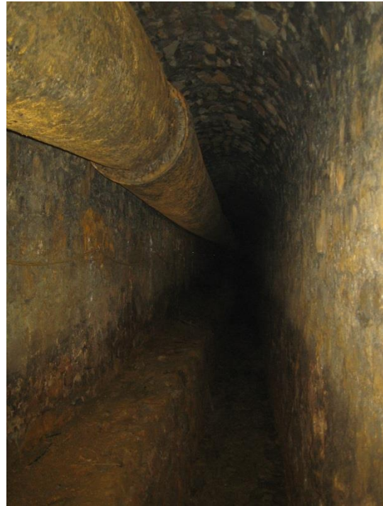
Rys. 2.7. Widok chodnika „Dechen” na południe od 47,3 m wybiegu: a) początek odcinka wyrobiska zabezpieczonego na całym obwodzie obudową kamienną, b) widok wyrobiska w obudowie kamiennej.
