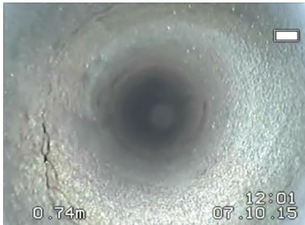
Rys.4.2.4. Poziome spękanie o rozwarciu 1 mm na głębokości 0,75 m.
