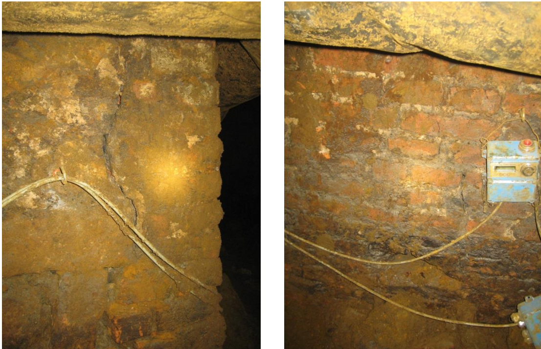
Rys. 2.6. Widok szczelin w rejonie północnego naroża odgałęzienia chodnika „Dechen” na wybiegu 87m
