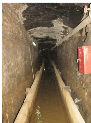
Rys. 2.8. Sztolnia pld. Koryto odprowadzające wodę do wylotu.
