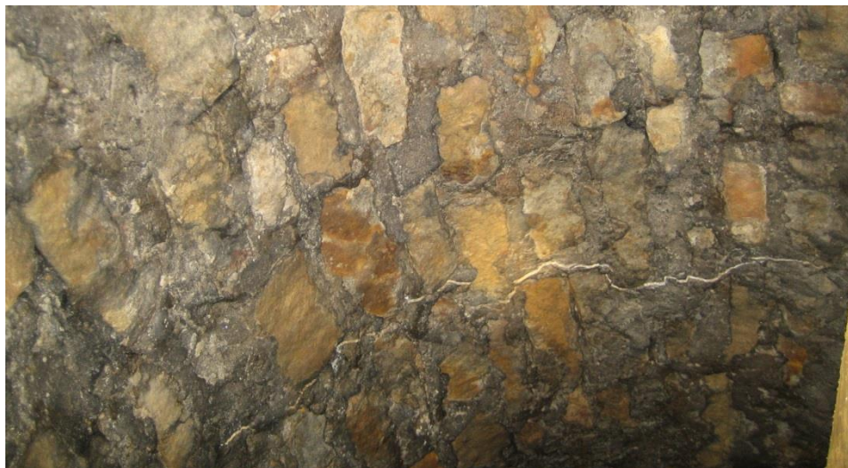
Rys. 2.2. Poprzeczna rysa o rozwarcu do ok. 3 mm na wybiegu ok. 61 m widoczna na całym obwodzie obudowy
