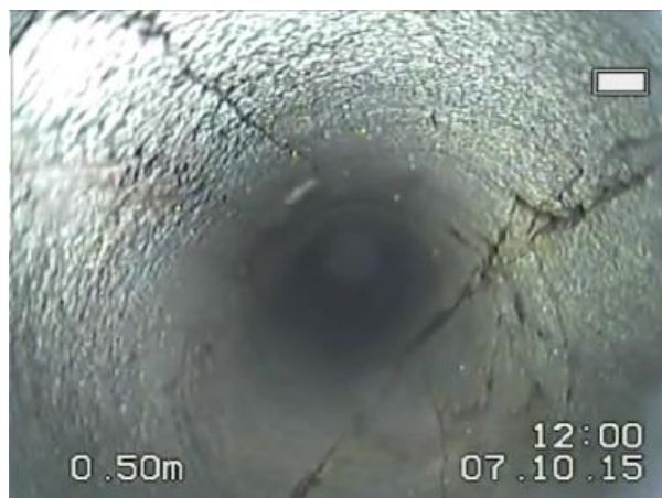
Rys.4.2.3. Sieci przecinających się skośnych spękań
