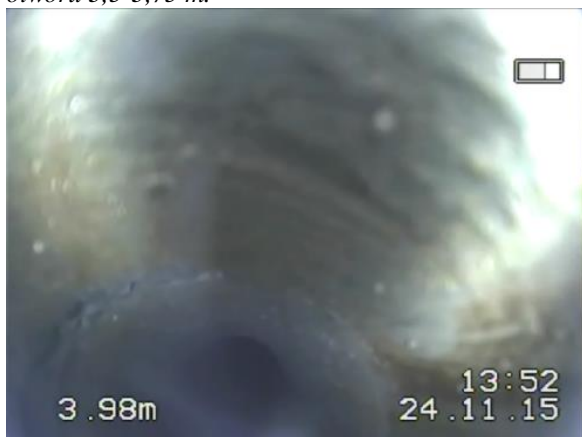
Rys.4.9. Poziome spękanie o rozwarciu 3 mm na głębokości 4,0 m.
