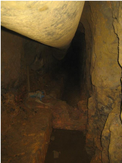
Rys. 2.6. Widok chodnika „Dechen” na wybiegu na wybiegu 40 – 47,3 m: a) widok przytamek na wybiegu 40 m, b) widok ociosu zachodniego zabezpieczonego murem kamiennym
