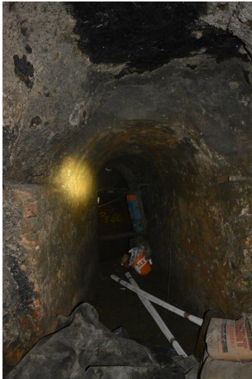
Rys. 2.3. Obudowa murowa z cegły wykonana w przecince nr 9 „Luiza”.
