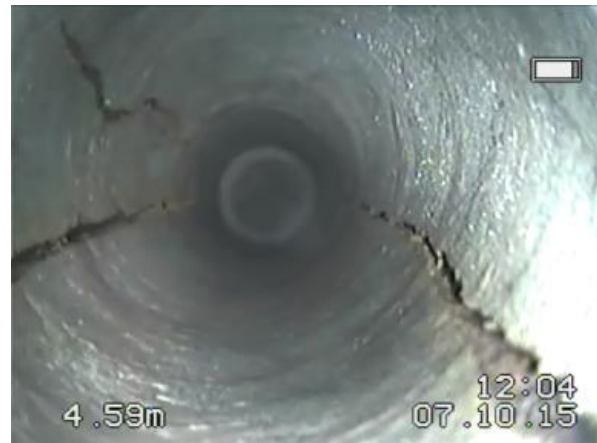
Rys. 4.2.11. Silne pionowe spękania o rozwarcu do 3 mm na głębokości 4,45-5,0 m.
