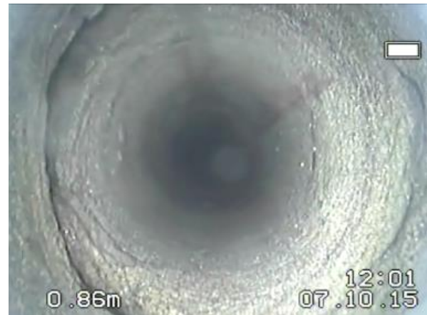
Rys.4.2.5. Poziome spękanie na głębokości 0,9 m o rozwarciu 5 mm.
