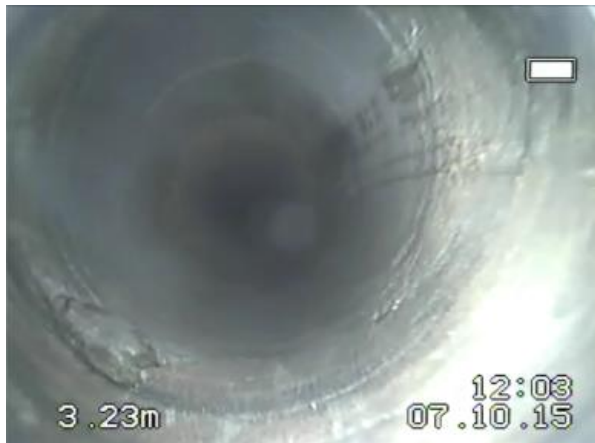
Rys.4.2.10. Ubytki skalne o wielkości do 10 mm.
