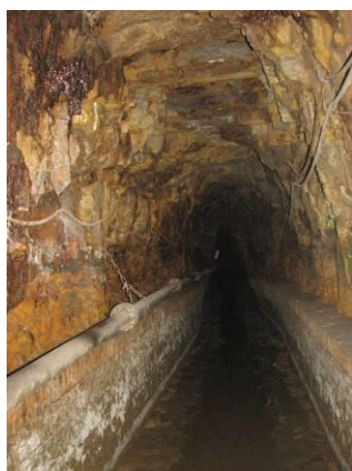
Rys. 2.7. Sztolnia ptn. Koryto odprowadzające wodę do wylotu.
