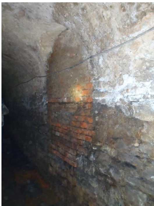
Rys. 2.2.1. Zamurowany wlot do Przecinki X „Reden północny” w ociosie północnym Sztolni południowej
