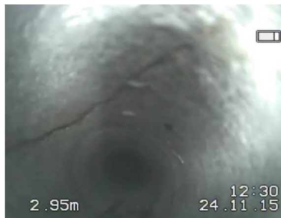
Rys.4.2.16. Skośne spękanie o rozwarciu 1 mm.
