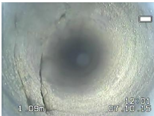
Rys.4.2.6. Skośne spękania poszerzające się do rozwarcia 10 mm.
