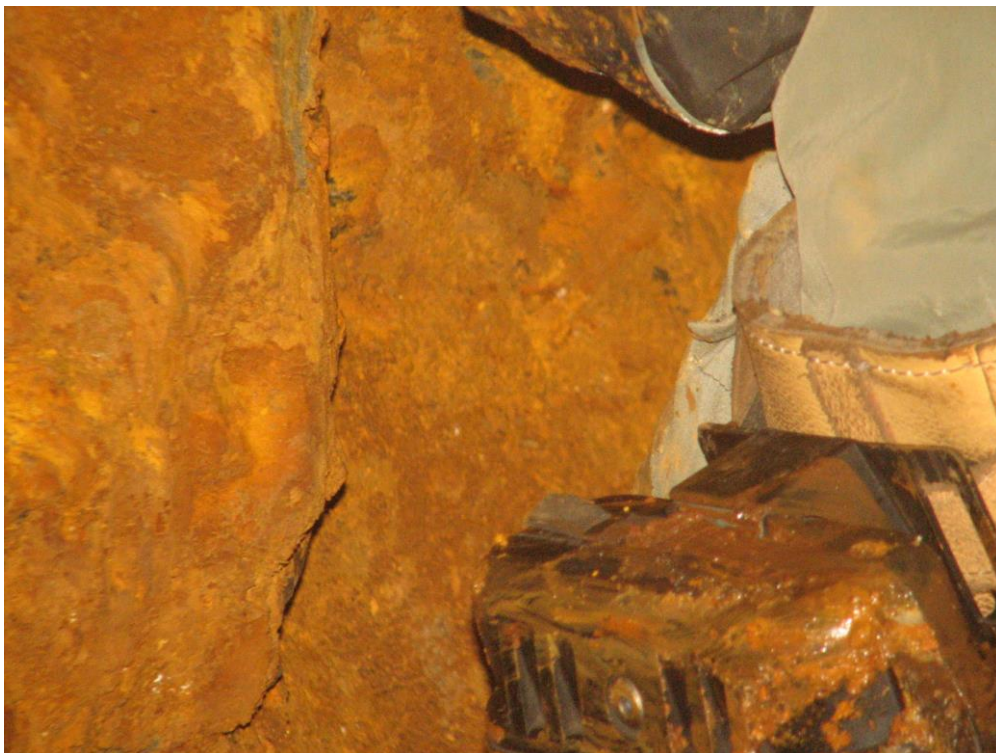
Rys. 2.3. Spękania w ociosie zachodnim
