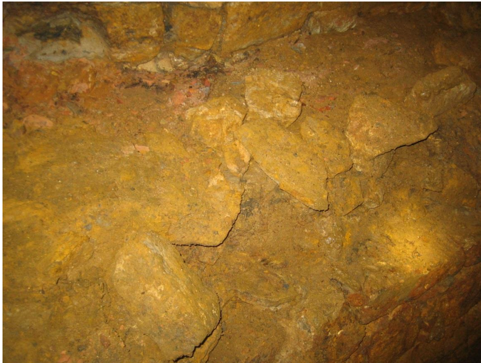
Rys. 2.9. Widok fragmentu rozluzowanej i uszkodzonej półki z kamienia naturalnego stanowiącej brzeg kanału wodnego
