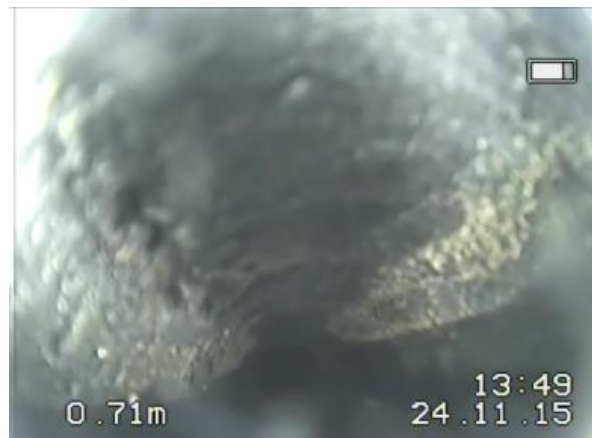
Rys.4.4. Pionowe spękanie o rozwierciu 1 mm.
