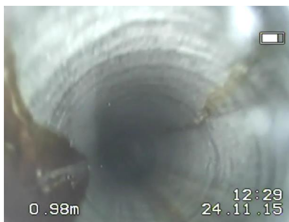
Rys.4.7. Spękania skośne ( 80^\circ ) o rozwarciu 1 mm.
