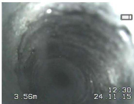
Rys.4.11. Spękania skośne o rozwarciu do 1 mm.
