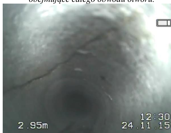
Rys.4.10. Skośne spękanie o rozwarciu 1 mm.
