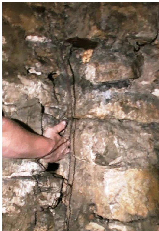
Rys.5.35. Brak powiązania obudowy odcinka zawężonego z odcinkiem poszerzonym w miejscu poszerzenia Sztolni
