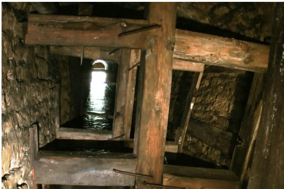
Rys.5.31. Widok odcinka wyrobiska za obwałem zabezpieczonego drewnianą konstrukcją wzmacniającą
