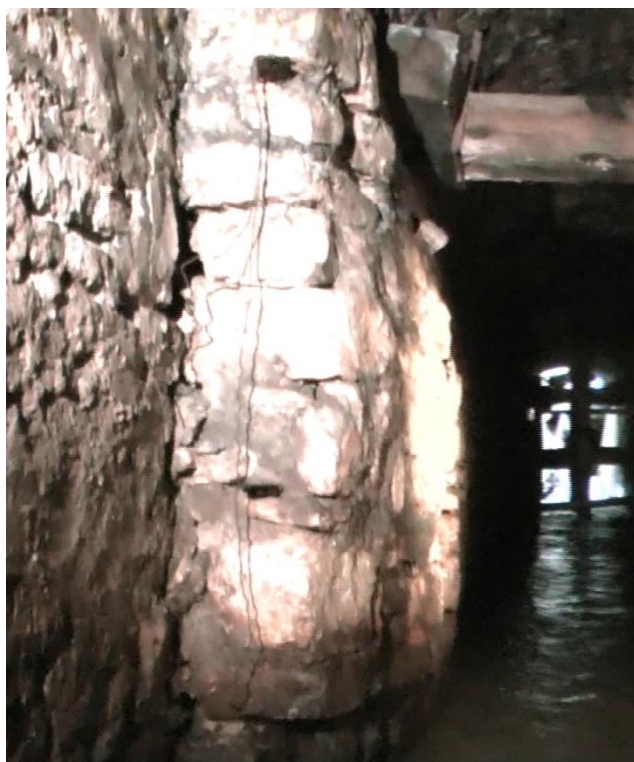
Rys.5.35. Brak powiązania obudowy odcinka zawężonego z odcinkiem poszerzonym w miejscu poszerzenia Sztolni
