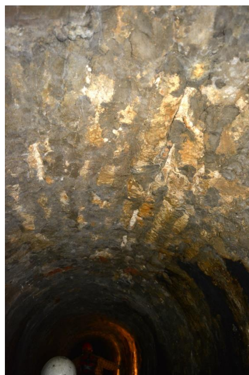
Rys.5.24. Nacieki barwy brunatnej występujące na obmurzu ociosu północnego oraz ubytki obmurza na głębokość do ok. 5 mm
