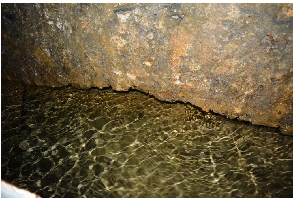
Rys.5.6. Widok podmytego muru w ociosie północnym wyrobiska
