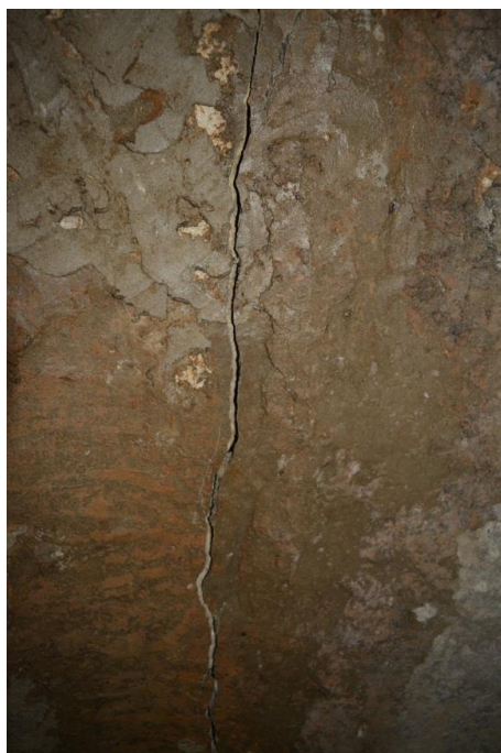
Rys.5.13. Widok szczeliny biegnącej w stropie wyrobiska na długości ok. 27 m
