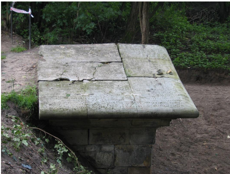
Rys.2.7. Zadaszenia portalu widok od strony północnej. Widoczne ułożenie płyt z piaskowca i wyrzeźbione na murze napisy.
