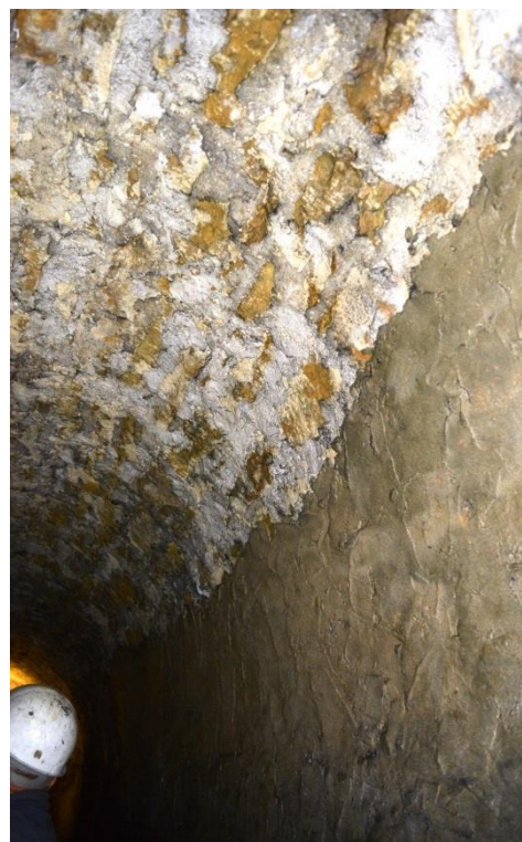
Rys.5.15. Widok odcinka wrobiska z otynkowanymi ociosami
