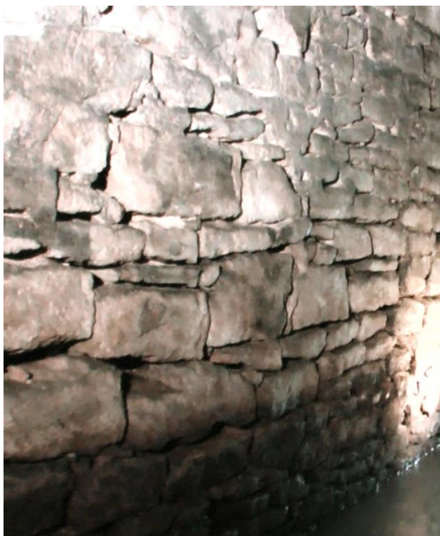
Rys.5.36. Widok rozluźnianego ociosu sztolni z licznymi ubytkami zaprawy w spoinach
