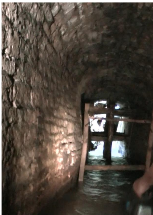
Rys.5.32. Przemieszczenie ociosu północnego Sztolni w kierunku światła wyrobiska
