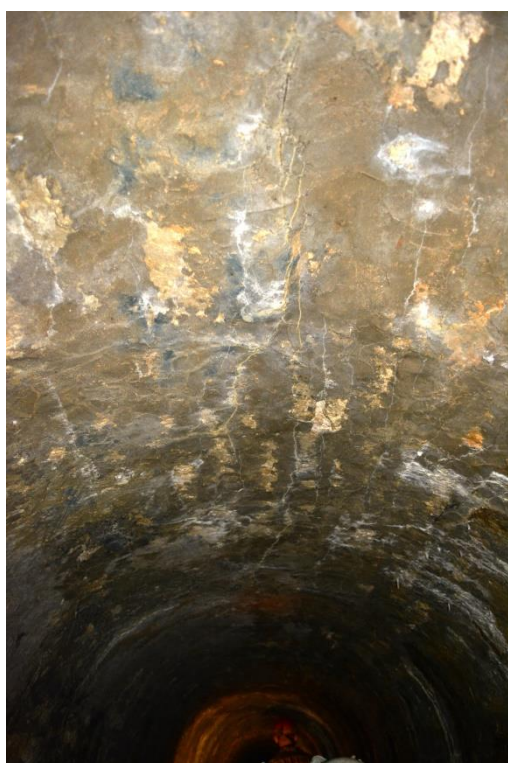
Rys.5.23. Widok spękań w stropie wyrobiska o rozwierciu do ok. 3 mm
