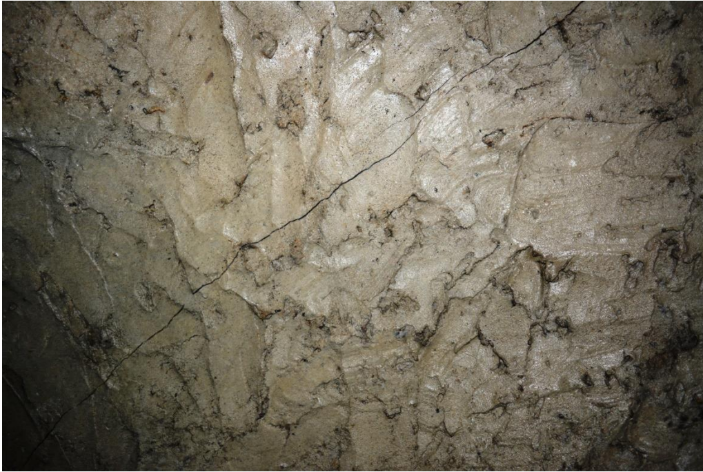
Rys.5.9. Widok spękań w stropie wyrobiska na wybiegu ok. 241 – 251 m.
