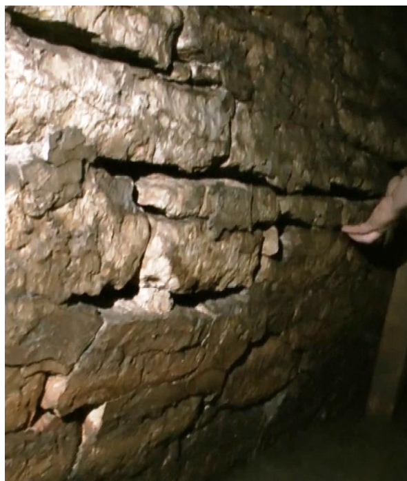
Rys.5.33. Widok rozluźnianego materiału obudowy
