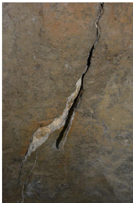
Rys.5.13. Widok szczeliny biegnącej w stropie wyrobiska na długości ok. 27 m
