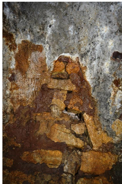
Rys.5.21. Widok kolejnego miejsca wymycia zaprawy w ociosach wyrobiska
