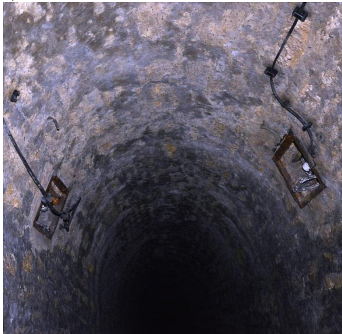
Rys.5.5. Widok początkowego odcinka sztolni w kierunku zachodnim od Szybu „Ewa”: a) gniazdo dla belki pomostu, b) gniazda oświetlenia elektrycznego.
