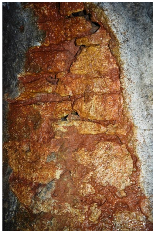
Rys.5.19. Widok miejsca wymycia zaprawy w ociosach wyrobiska
