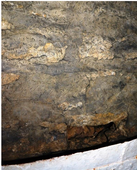
Rys.5.5. Widok początkowego odcinka sztolni w kierunku zachodnim od Szybu „Ewa”: a) gniazdo dla belki pomostu, b) gniazda oświetlenia elektrycznego.
