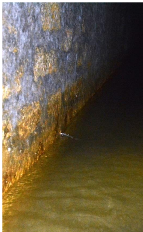
Rys.5.8. Wypływ wody zza obmurza ociosu południowego na wybiegu ok. 211 m
