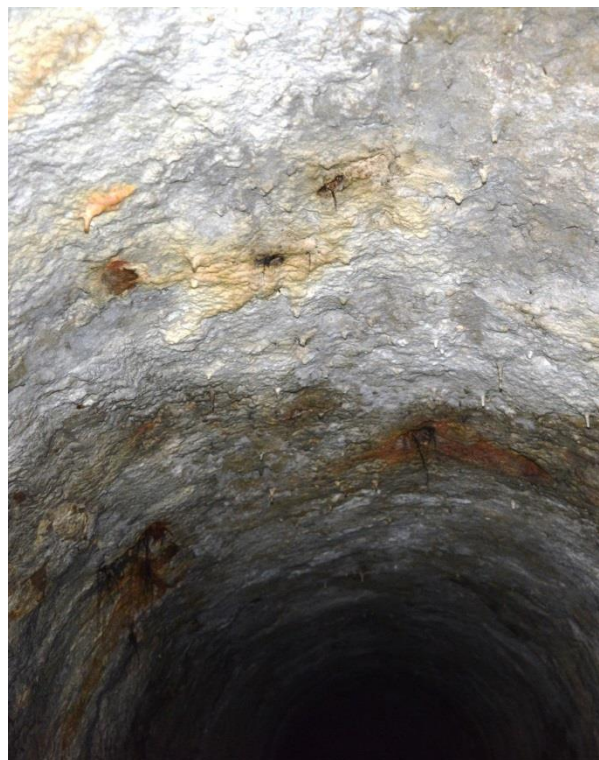
Rys.5.22. Widok korzeni roślin przerastających przez obudowę
