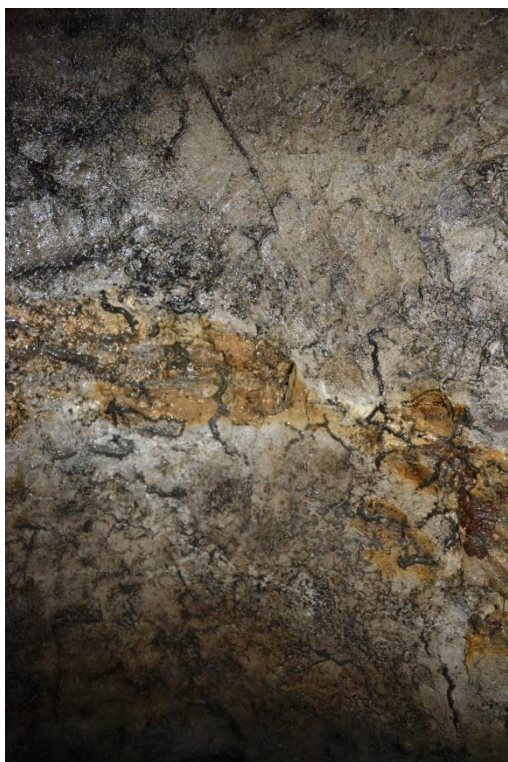
Rys.5.7. Widok szczeliny w stropie wyrobiska z wkropleniami wody na wybiegu ok. 170 m
