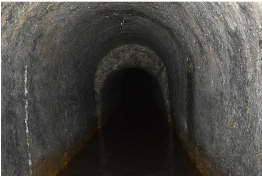
Rys.5.10. Rejon zawężenia przekroju poprzecznego wyrobiska
