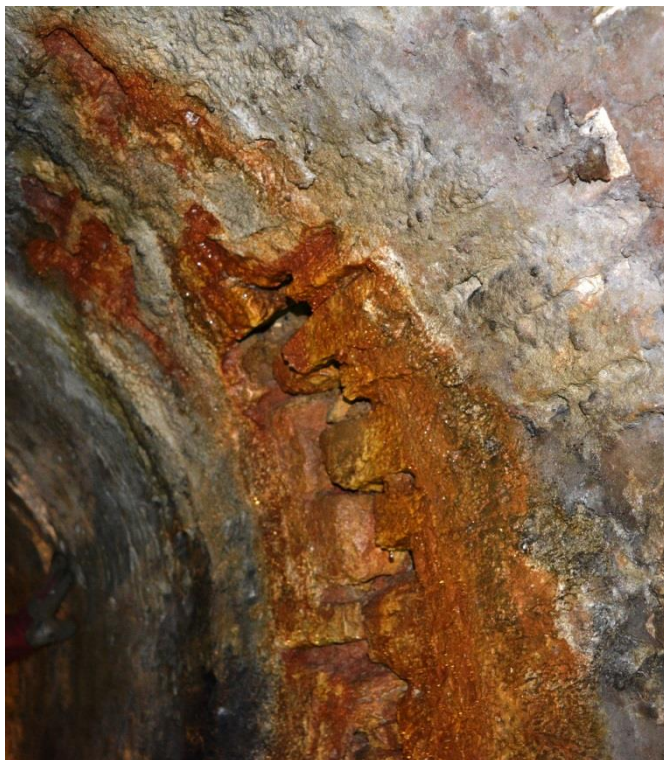
Rys.5.19. Widok miejsca wymycia zaprawy w ociosach wyrobiska
