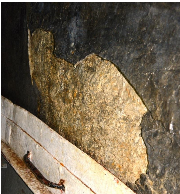
Rys.5.14. Odspojenie warstwy tynku w ociosie północnym wyrobiska
