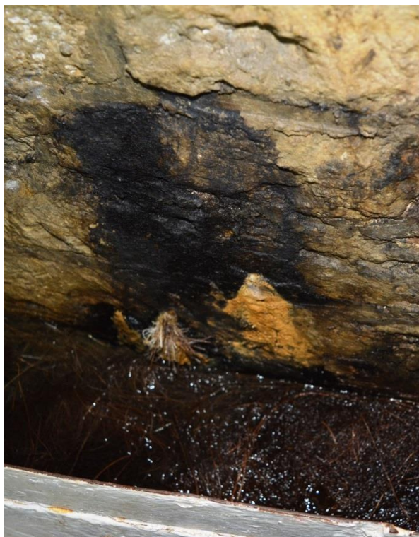
Rys.5.22. Widok korzeni roślin przerastających przez obudowę
