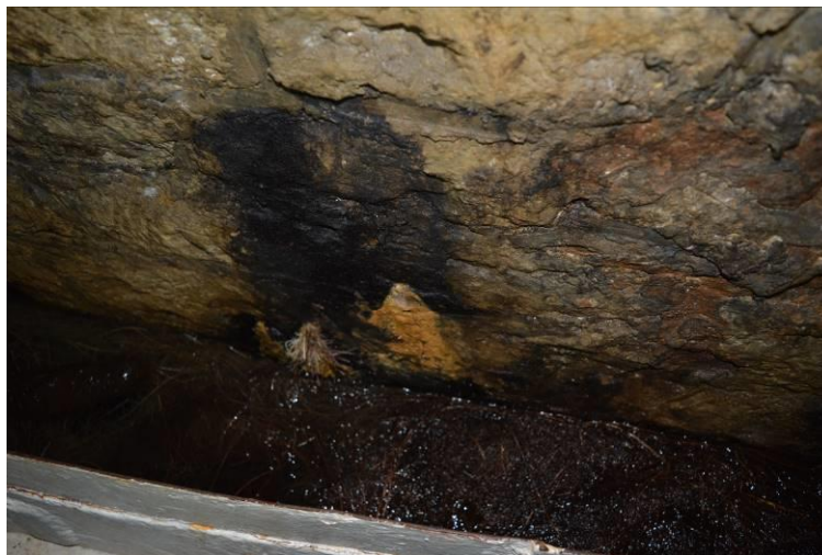
Rys.5.51. Korzenie wyrastające spod posadowienia muru obudowy.
