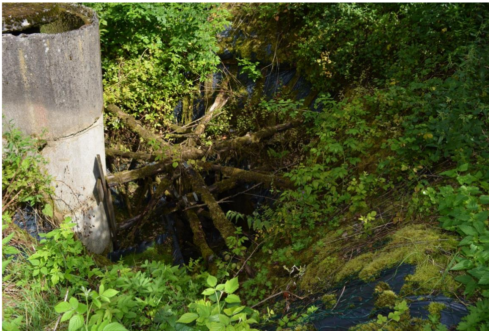
Rys.5.30. Widok zapadliska powstałego w wyniku zawалу stropu Sztolni Fryderyk
