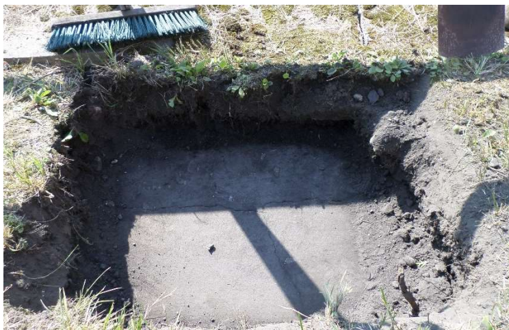
Rysunek 5 Odkrywki płyty betonowej
