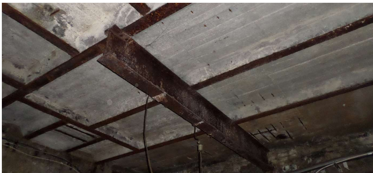
Rysunek 6 Dół stropu maszynowni - widoczne liczne ubytki
