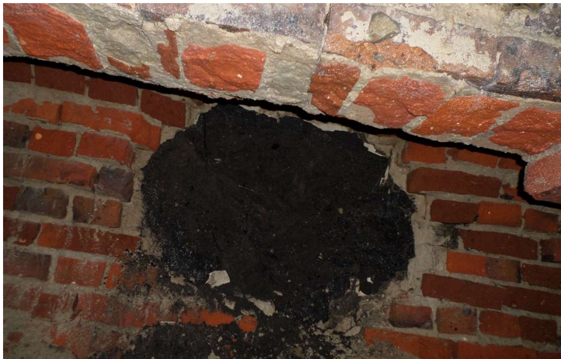
Rysunek 8 Widok ubytku w uszkodzonym murze
