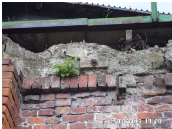
Rysunek 9 Widok betonowego wieńca z pozostałą konstrukcją stalową
