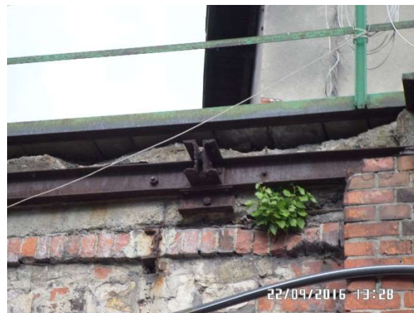
Rysunek 9 Widok betonowego wieńca z pozostałą konstrukcją stalową
