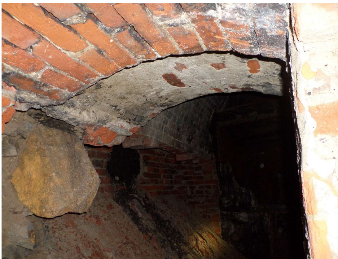
Rysunek 7 Uszkodzony mur wspierający łuk ceglany
