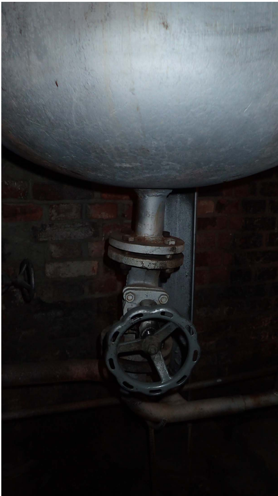
3.14. Odcinek rurociągu od zbiornika pary do zasuwy odcinającej dopływ pary do cylindrów lewego i prawego.
