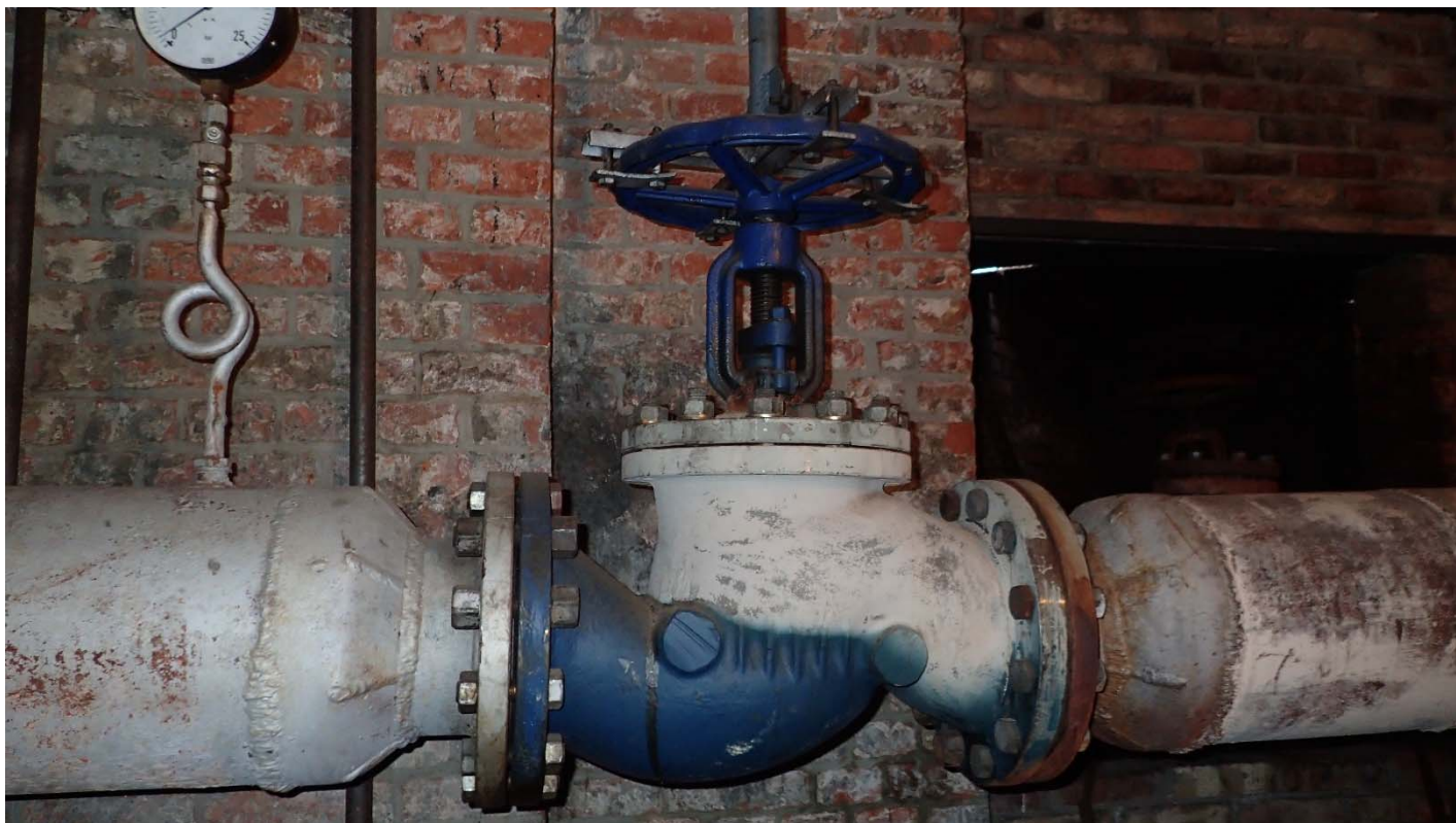
3.12. Zasuwy odcinające parowe na rurociągu przed zbiornikiem pary.
