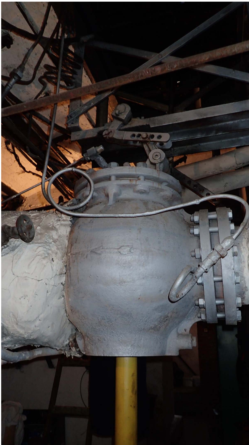
3.15. Zasuwa odcinająco-rozdzielająca.
