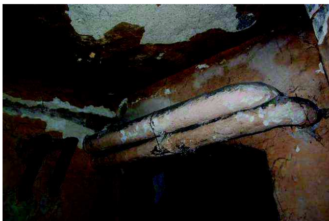
Fot. nr 13 Zachowana instalacja co.
