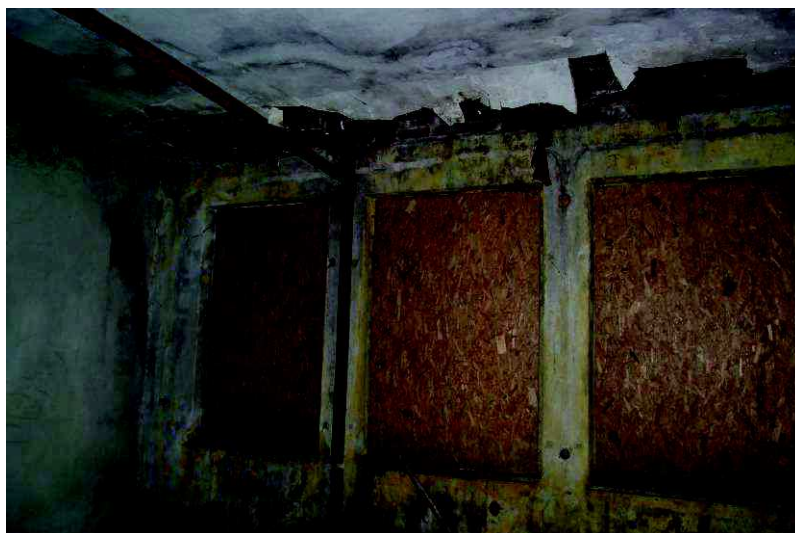
Fot. Nr 35 Pomieszczenie II piętra – uszkodzenia stropu nad pomieszczeniem, Widoczne prowizoryczne podparcie.
