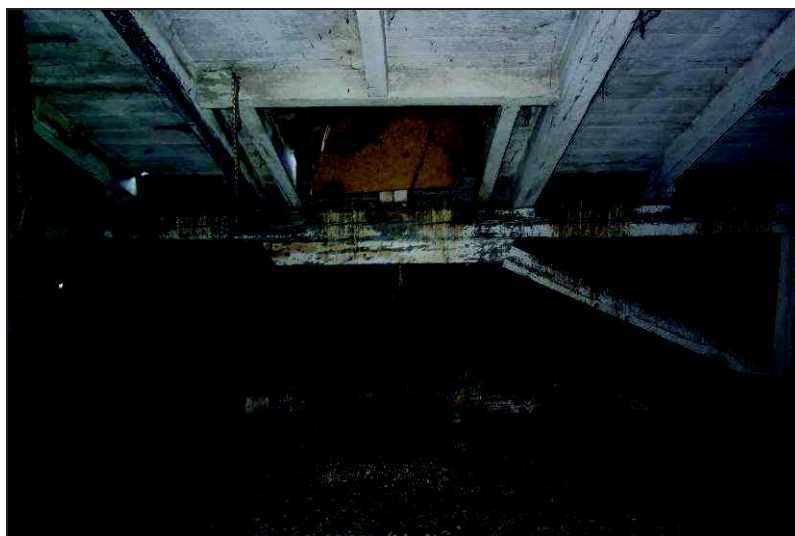
Fot. Nr 38 Pomieszczenie poddasza - zwaly odchodów ptasich, Uszkodzony dźwigar podtrzymujący krokwie dachowe – brak zastrzału, zdewastowana lukarna „wole oko”.
