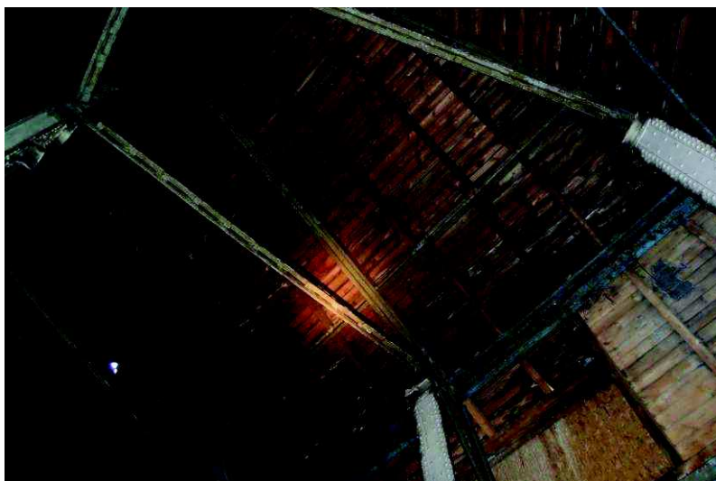
Fot. Nr 23 Deskowanie kopuły mansardowej zbiorników Widoczne zawilgocenia desek pokrycia.
