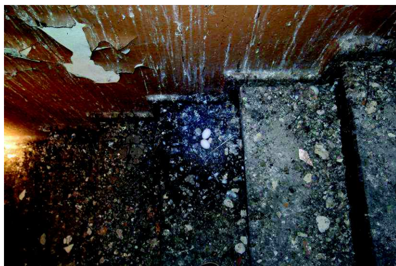
Fot. nr 37 Zagruzowane stopnie klatki schodowej II piętra.
