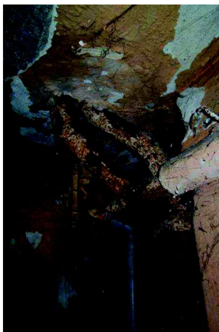
Fot. nr 7 Zachowana instalacja co i kanalizacyjna żeliwna i PVC.
