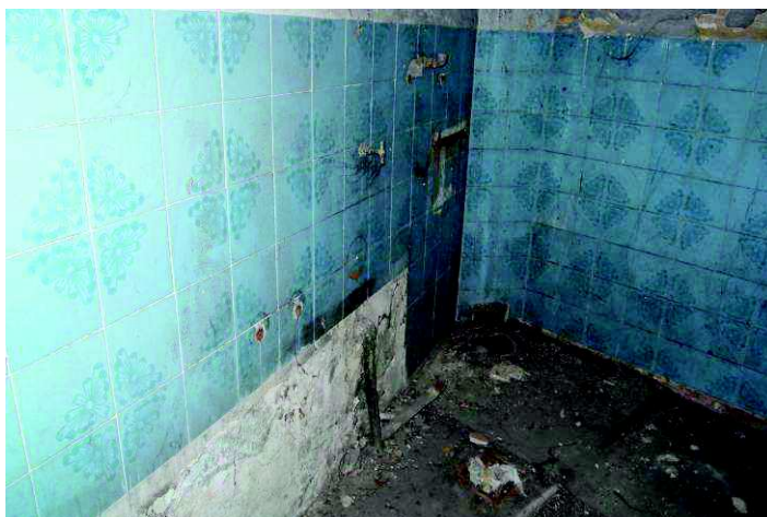
Fot. nr 47 Zdemontowane baterie i zawory wypływowe.
