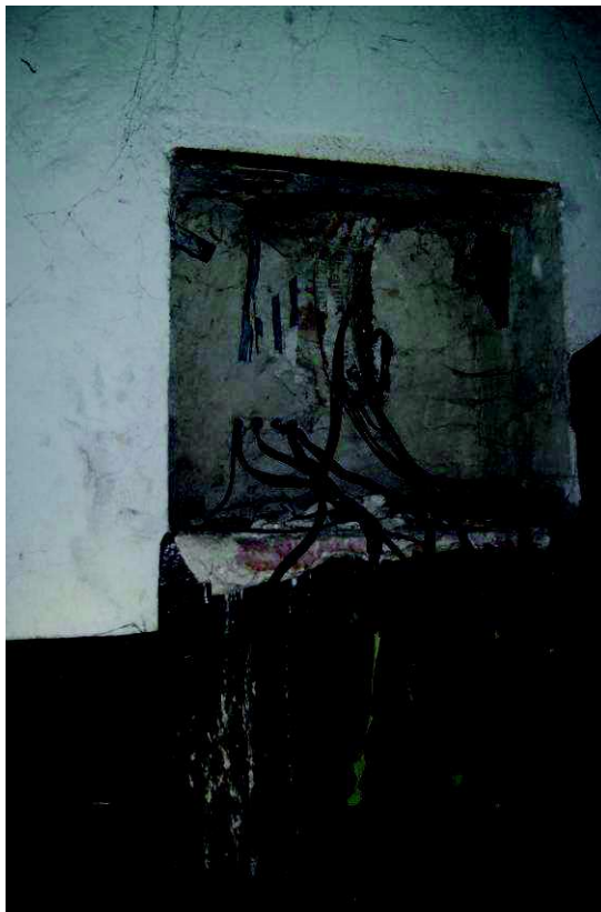
Fot. nr 40 Brak tablicy rozdzielczej z wyposażeniem.
