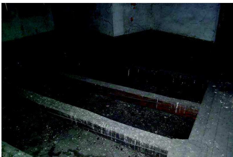
Fot. Nr 34 Pomieszczenie II piętra – zdemonstrowane deskowanie podłogi drewnianej
