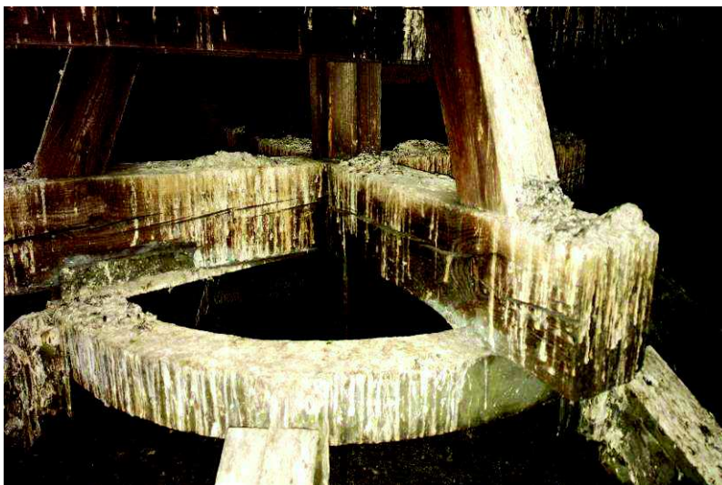
Fot. Nr 24 Zanieczyszczona odchodami ptasimi podstawa słupka latarni dachowej.
