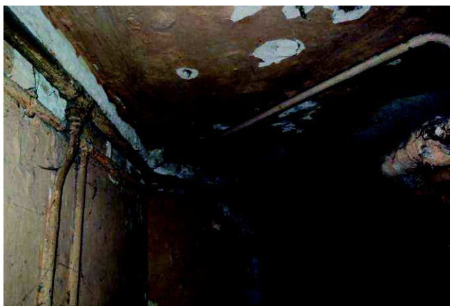
Fot. nr 9 Zachowane instalacje wodociągowa i co.
