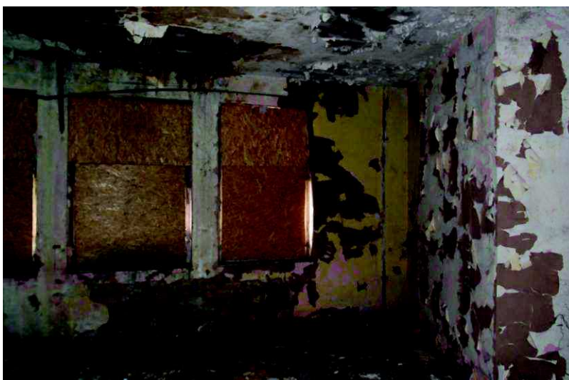
Fot. Nr 33 Widoczny fragment zniszczonego stropu piętra, grożący zawaleniem konstrukcji stropu
