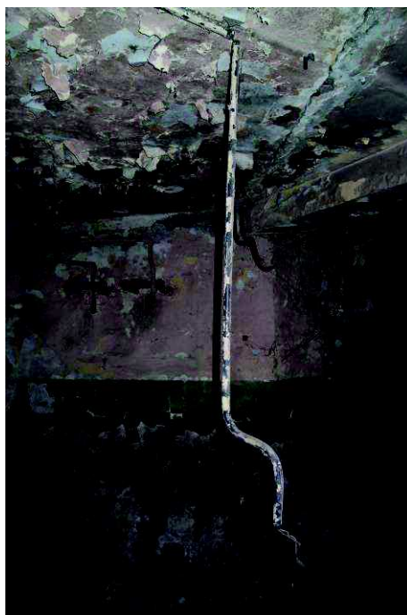
Fot. nr 42 Wyrwane przewody opraw.
