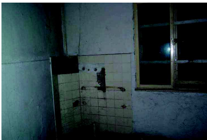
Fot. nr 46 Zdemontowane el. kanalizacji odpływowej umywalki.
