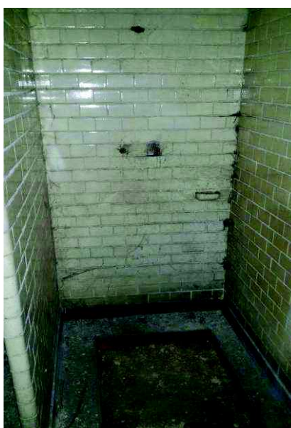
Fot. nr 48 . Zdemontowane baterie i zawory wypływowe.
