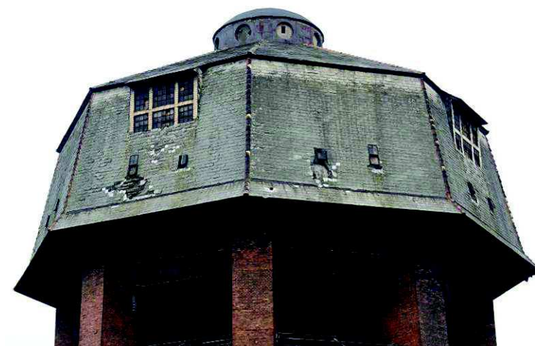
Fot. Nr 17 Uszkodzenia pokrycia dachowego mansardy zbiorników
