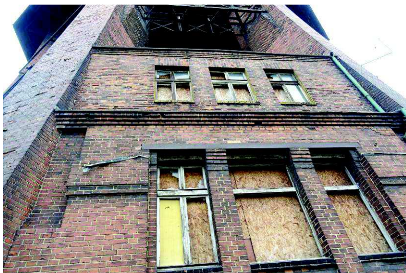
Fot. Nr 28 Zdewastowana stolarka okienna II piętra i poddasza, uszkodzone obróbki blacharskie gzymsów przyokiennych, uszkodzenia cegieł gzymsu II piętra.
