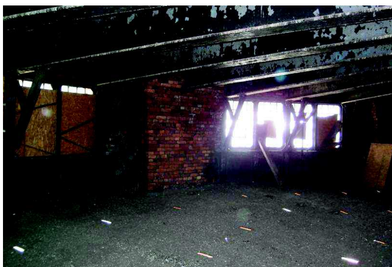
Fot. Nr 19 Zanieczyszczone pokrycie stropu podziornikowego Widoczne złuszczenie farby na belkach stropu nośnego zbiorników.
