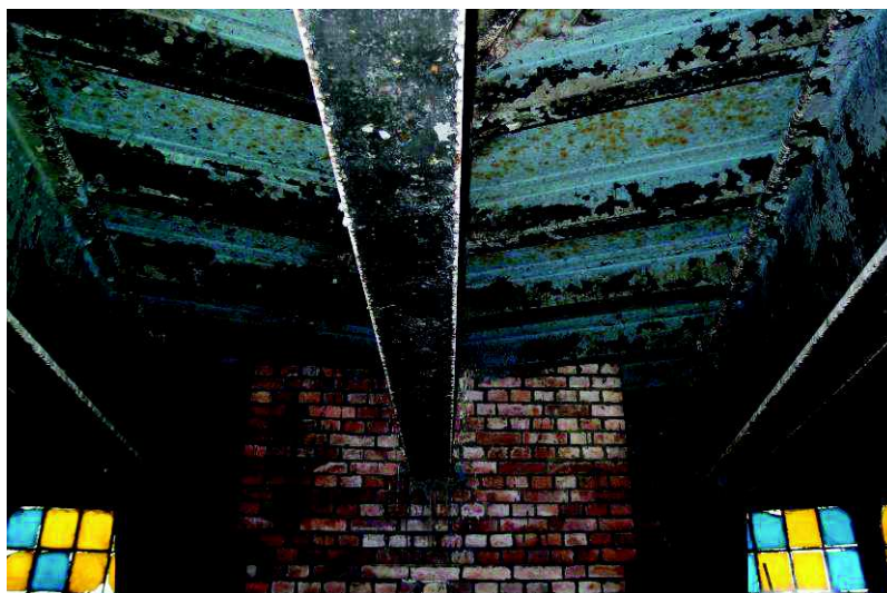
Fot. Nr 20 Łuszczenie się farby na stropie nośnym zbiorników Widoczne wykwity rdzy na blasze pokrycia.
