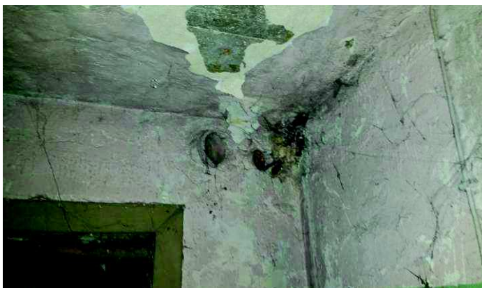
Fot. nr 51 . Przepusty po zdemontowanych rurach co.
