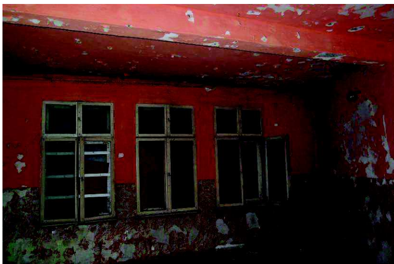
Fot. Nr 32 Pomieszczenie parteru - zniszczenia wymalowań ścian i sufitu, Widoczne zamurowania otworów okiennych.
