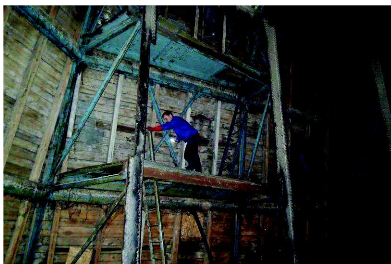
Fot. Nr 22 Skorodowania oraz złuszczenia farby konstrukcji stalowej kopuły mansardowej zbiorników.
