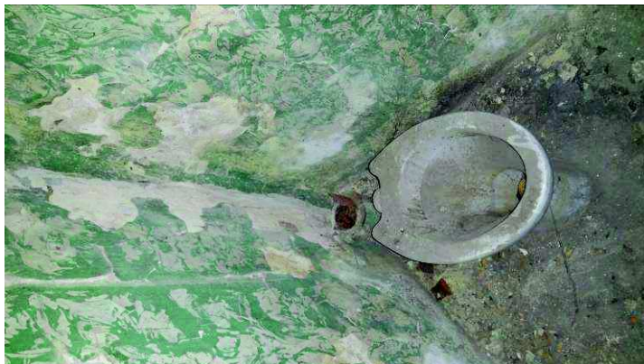
Fot. nr 45. Uszkodzone podejście kanalizacyjne odpływu muszli klozetowej.
