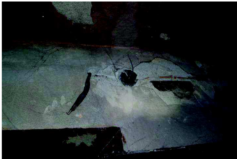
Fot. nr 41 . Zdekompletowane podejścia do puski elektrycznej i wyrwane przewody.
