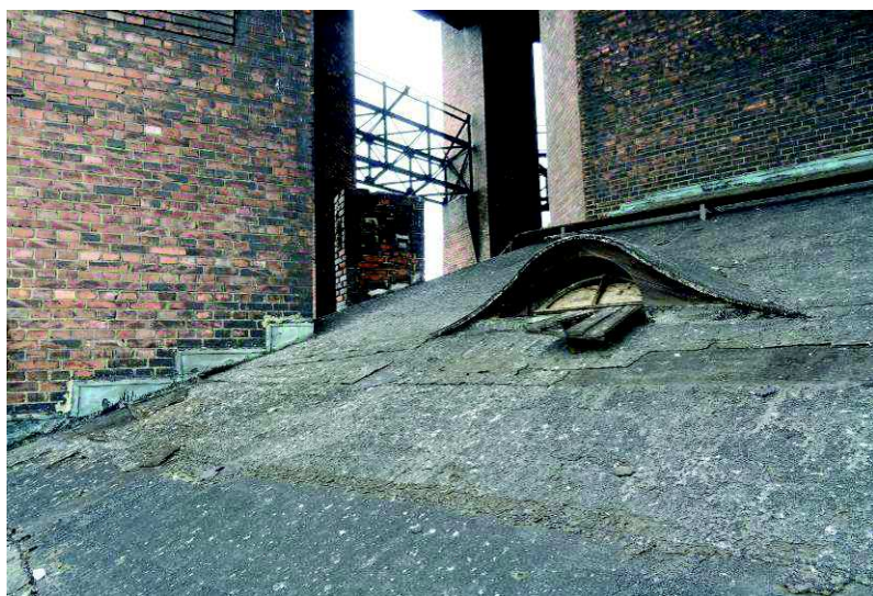
Fot. Nr 27 Zdewastowana lukarna typu „wole oko”, zniszczone pokrycie papowe dachu.
