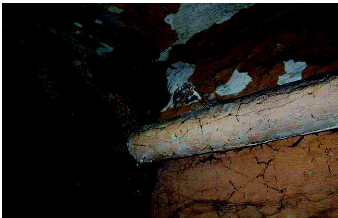
Fot. nr 50 . Silna korozja wżerowa oraz ubytki otuliny termoizolacyjnej.
