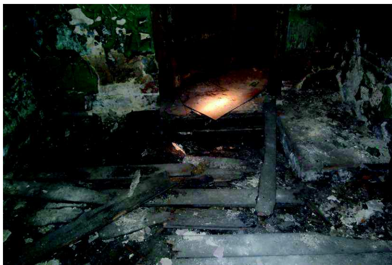
Fot. Nr 29 Zdewastowana podłoga drewniana w piwnicy.
