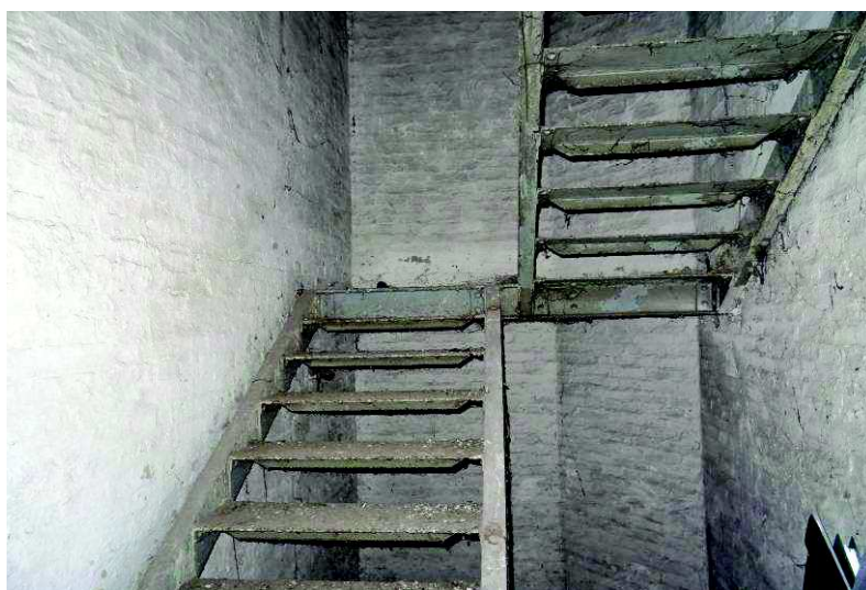
Fot. Nr 18 Brak poręczy na schodach trzonu.
