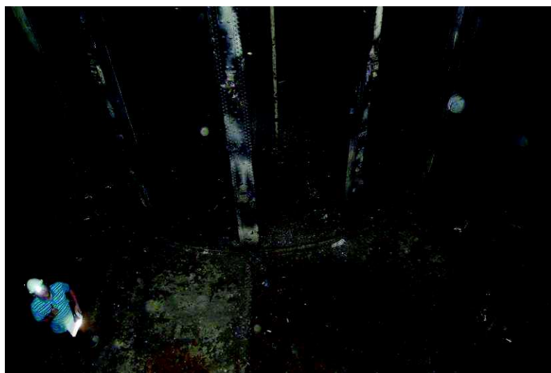
Fot. Nr 21 Korozja blach pokrycia stropu nośnego zbiorników Widoczne słupy płaszcza międzybniowego.
