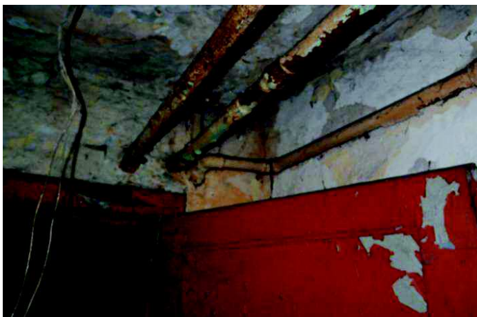
Fot. nr 52. Silna korozja wżerowa oraz brak otuliny termoizolacyjnej.
