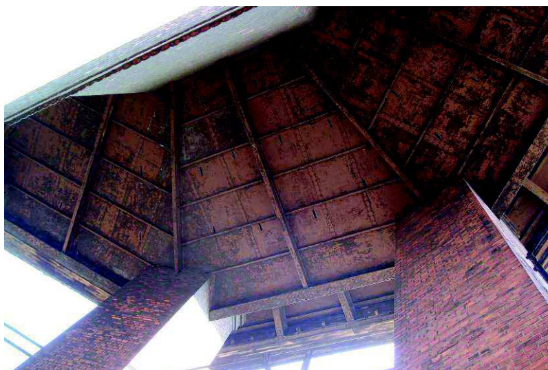
Fot. Nr 16 Skorodowana powierzchnia zewnętrzna stropu podziornikowego
