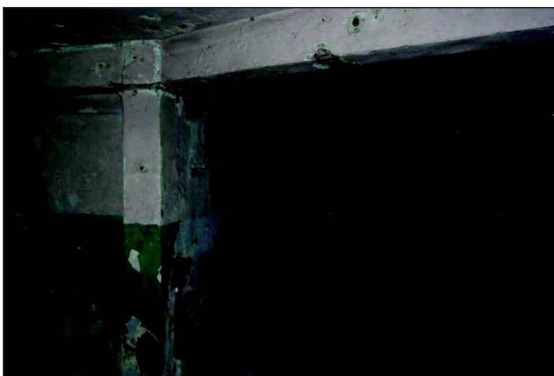
Fot. Nr 31 Uszkodzony fragment piwnicznego żelbetowego rygla ramy okrężnej. Widoczne odpryski korozyjne na powierzchni rygla i sufitu, zagruzowana posadzka pomieszczenia.
