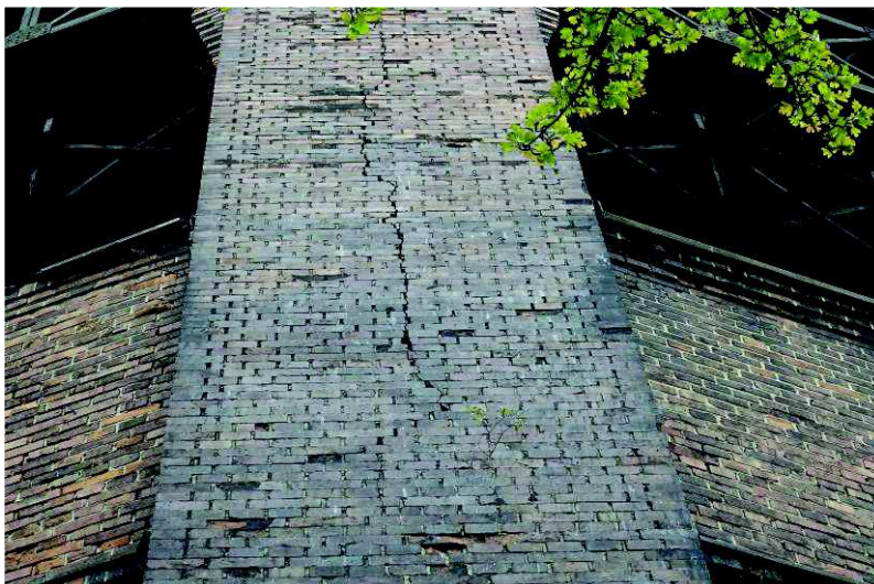
Fot. Nr 15 Spękanie słupa wieży, korozja lic cegieł
