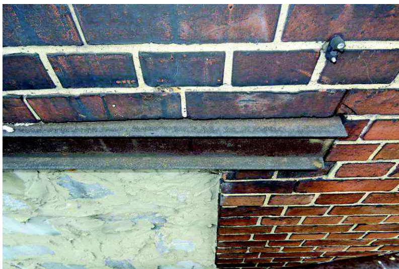
Fot. Nr 27 Luźne, skorodowane nadproże stalowe nad oknem parteru.
