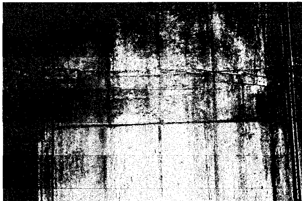
Fot.1. Głowica szybowa – obmurze z betonu monolitycznego, lokale ubytki lica obmurza na głębokość do 1 cm, widoczna struktura deskowania i przerwy technologiczne układania mieszanki betonowej.
