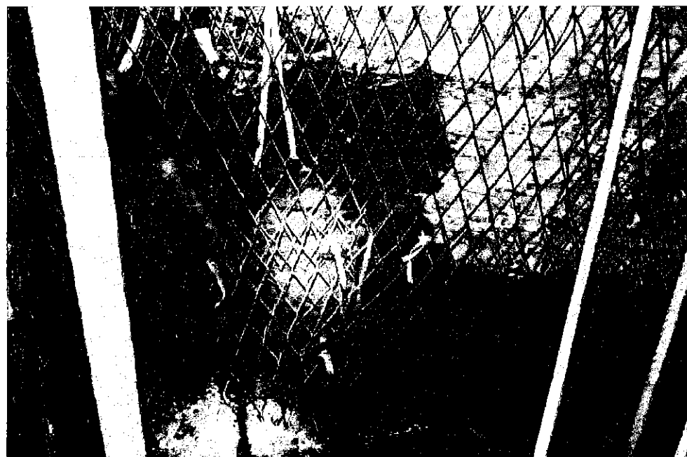
Fot.12. Głębokość ok. 108÷111 m – obmurze murowe z betonitów, po stronie E wnętrza o głębokości ok. 2m i wysokości ok. 3,5m. Czoło wnętrza bez obudowy, zabezpieczone przykotwioną siatką stalową MM.
