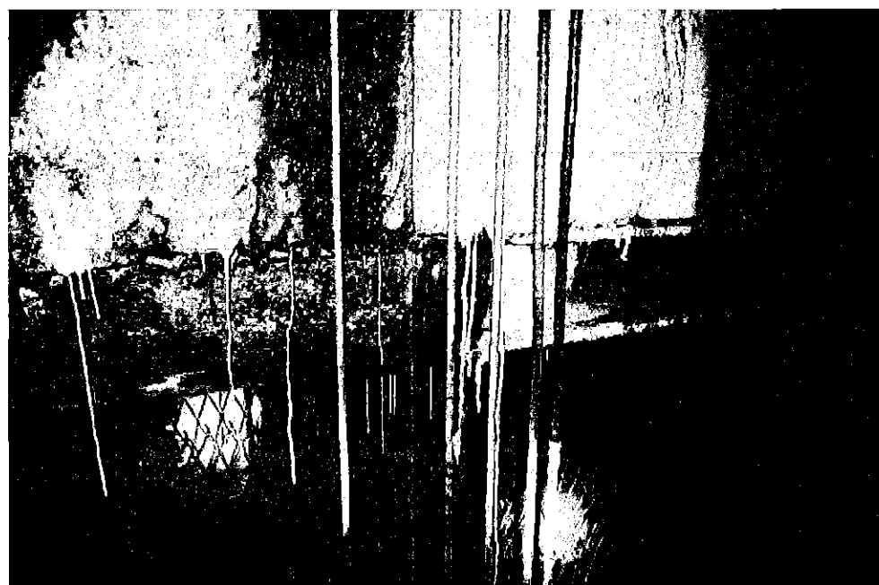
Fot.13. Głębokość ok. 108÷111 m – obmurze murowe z betonitów, po stronie E wnętrza o głębokości ok. 2m i wysokości ok. 3,5m. Strop wnętrza prosty, zabezpieczony belką nadprożową o przekroju dwuteowym, czoło wnętrza bez obudowy, zabezpieczone przykotwioną siatką stalową MM.
