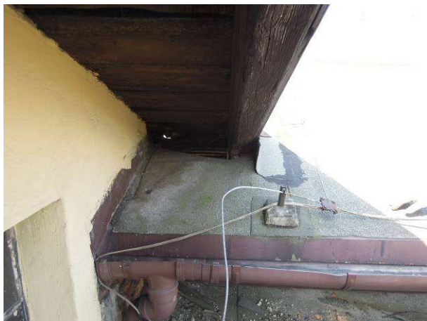
Fot. 7. Widok uszkodzonych obróbek
